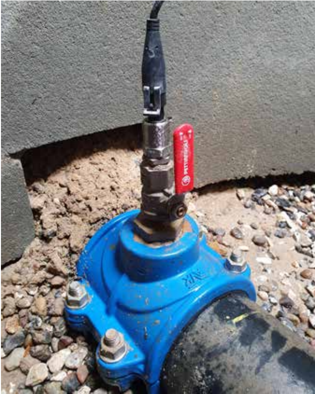
Grâce à leur fonctionnement sans fil, les capteurs de pression peuvent être installés sur n'importe quel point du réseau de distribution.
