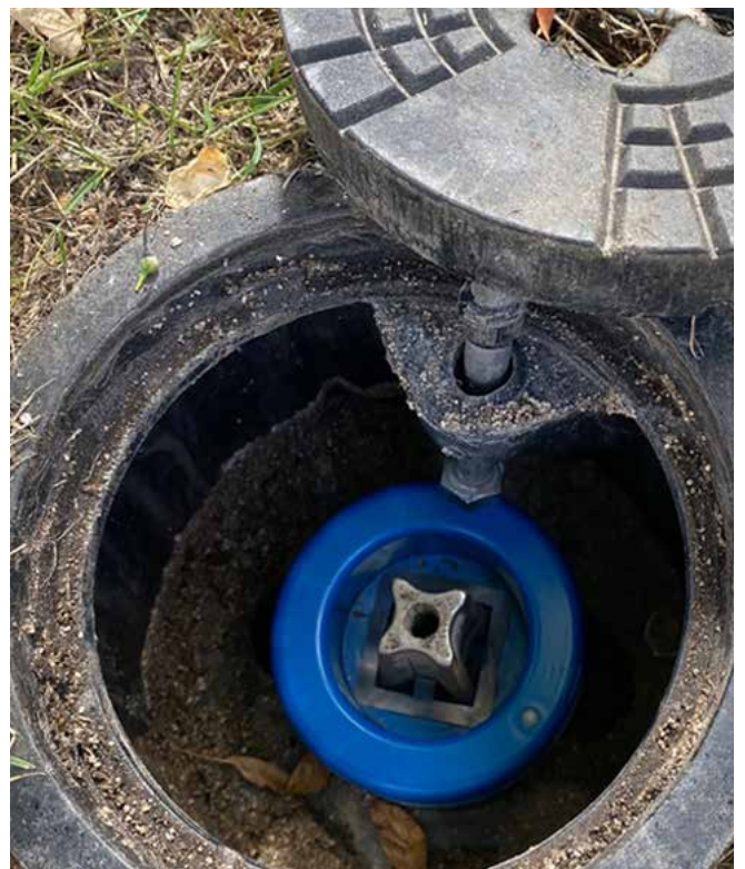
Capteur de position VIDİ installé dans une bouche à clé
